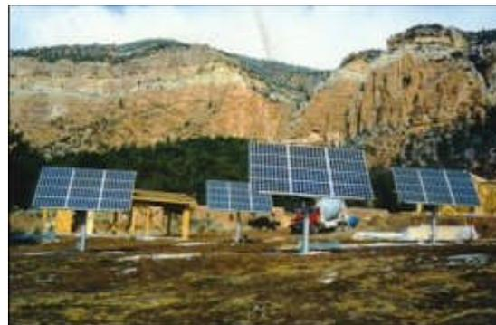
**Le système de base d'Array Technologies peut porter jusqu'à 3 kW de panneaux.**
