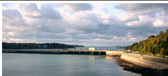
Barrage de la Rance
